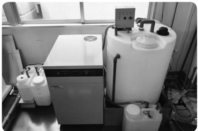
像廃液削減装置導入を富士フィルム株式会社様より提案いただき、導入いたしました。これはサーマルプレートプロセサー(CTP)から排出された現像廃液を濃縮処理することにより、8分の1(体積比)の濃縮廃液にする環境にやさしい機器です。濃縮処理をすることにより、産業廃棄処理料が従来の8分の1となります。フル活用していけば、かなりの経費削減にもなるのではと期待されております。
