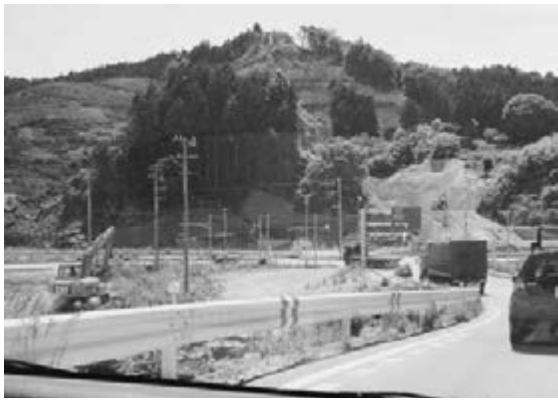
高台移転の山の切り出し
