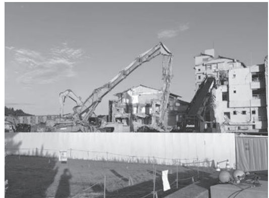
解体作業中の和倉温泉ホテル群
